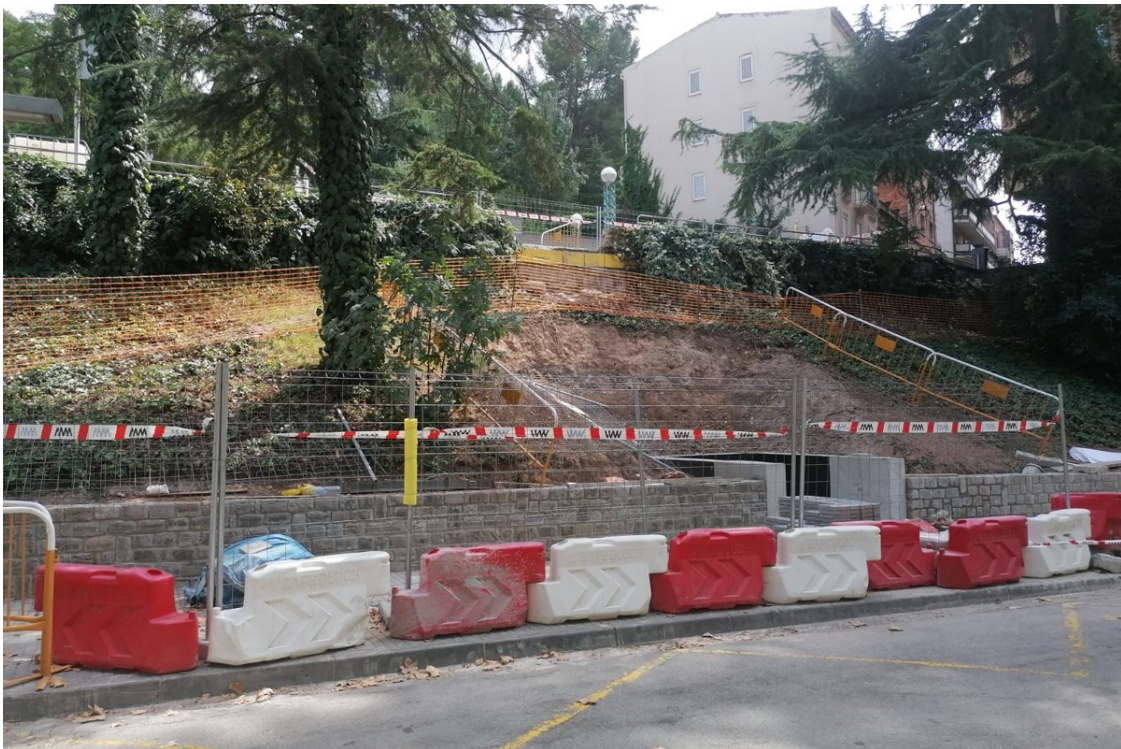
Obres per a l'ascensor vistes des del passeig Pere III | Aina Font Torra
