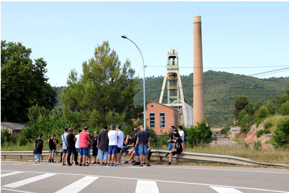
Grup de treballadors de Montajes Rus concentrats davant de la mina de Vilafruns | Mar Martí
