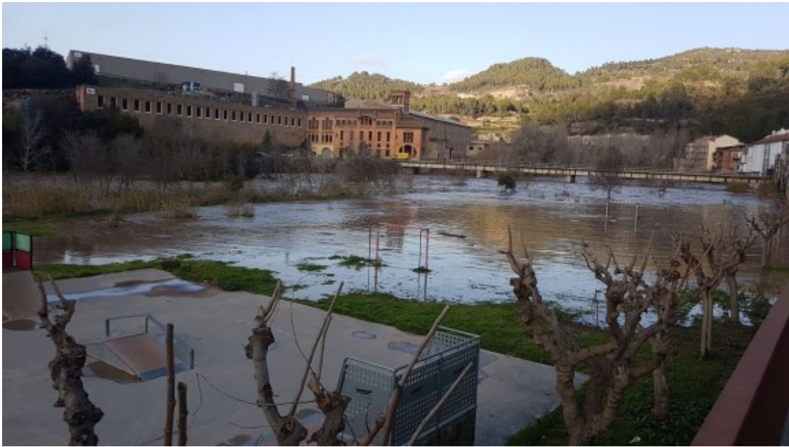
El camp de futbol de la Bauma, totalment inundat. Foto: AELB
