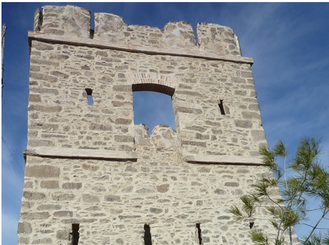
Torre dels Soldats d'Avinyó | DdeB
