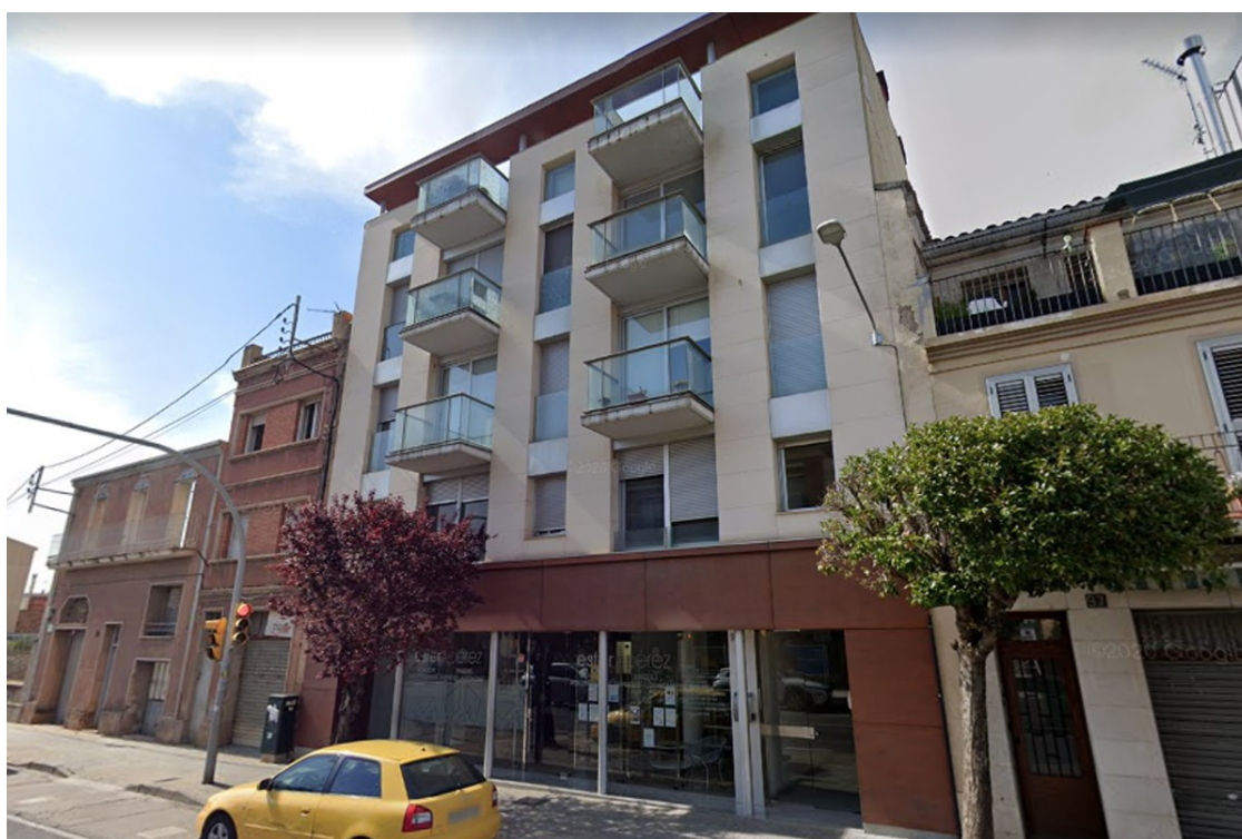
Edifici que ha estat evacuat a Sant Fruitós de Bages | GSV
