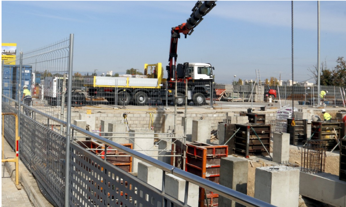
Imatge de les obres de l'hospital | ACN
