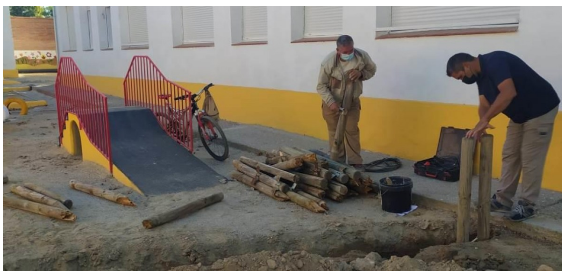
Operaris treballant en la sectorització del pati | Aj Almacelles
