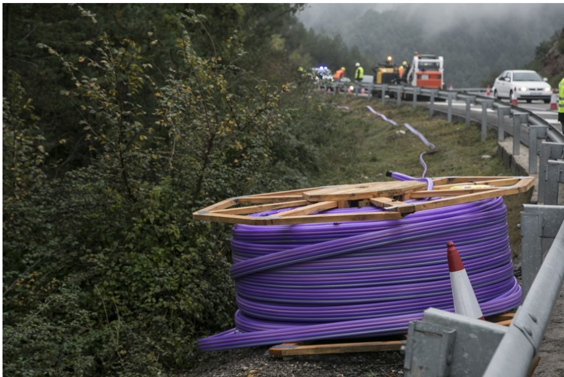
Treballs de desplegament de la fibra òptica de la Generalitat. | Govern
