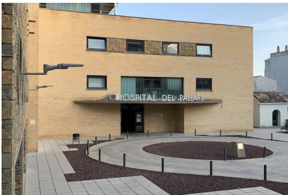
Entrada principal a l'Hospital Comarcal del Pallars | Jordi Ubach
