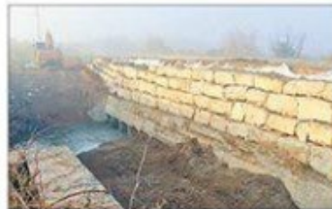
FOTO: Selena García / El talud reforzado por Endesa en el canal
