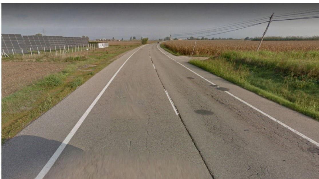
Imatge de la carretera LP-3322, en el tram Linyola-Mollerussa | Aj Linyola
