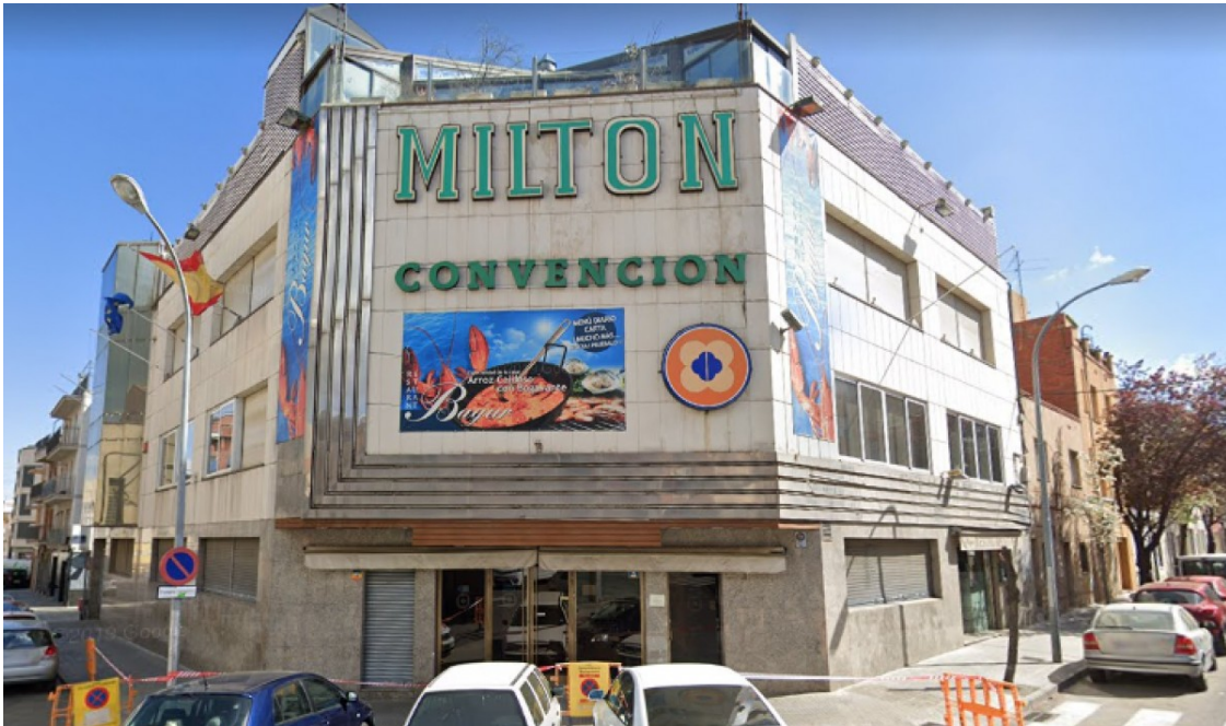
Façana de l'antiga sala de festes Milton Convención de Terrassa. | GSV
