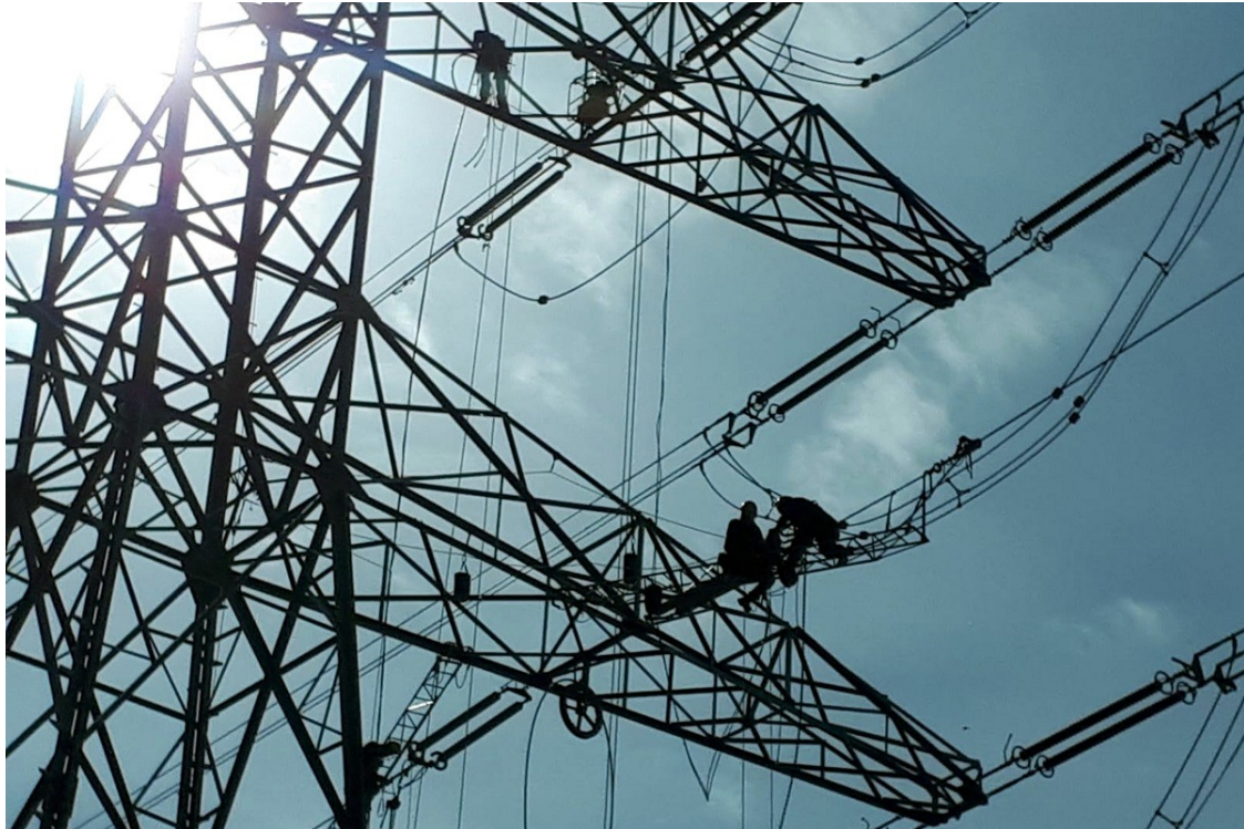
Operaris d'Endesa en una torre elèctrica | ACN
