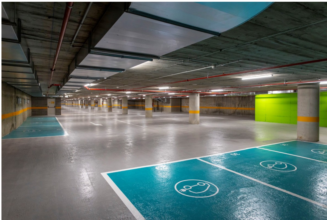
El nou aparcament soterrat a l'estació de FGC Terrassa Nacions Unides | FGC
