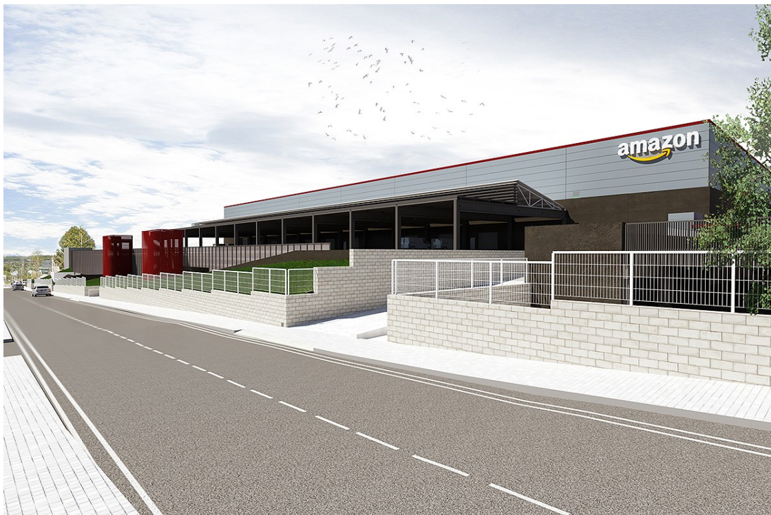
La instal·lació que tindrà Amazon a Rubí | Amazon
