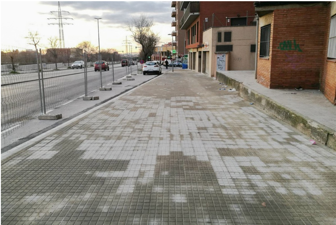
El tram de l'avinguda del Vallès on s'han dut a terme les obres. | Ajuntament de Terrassa
