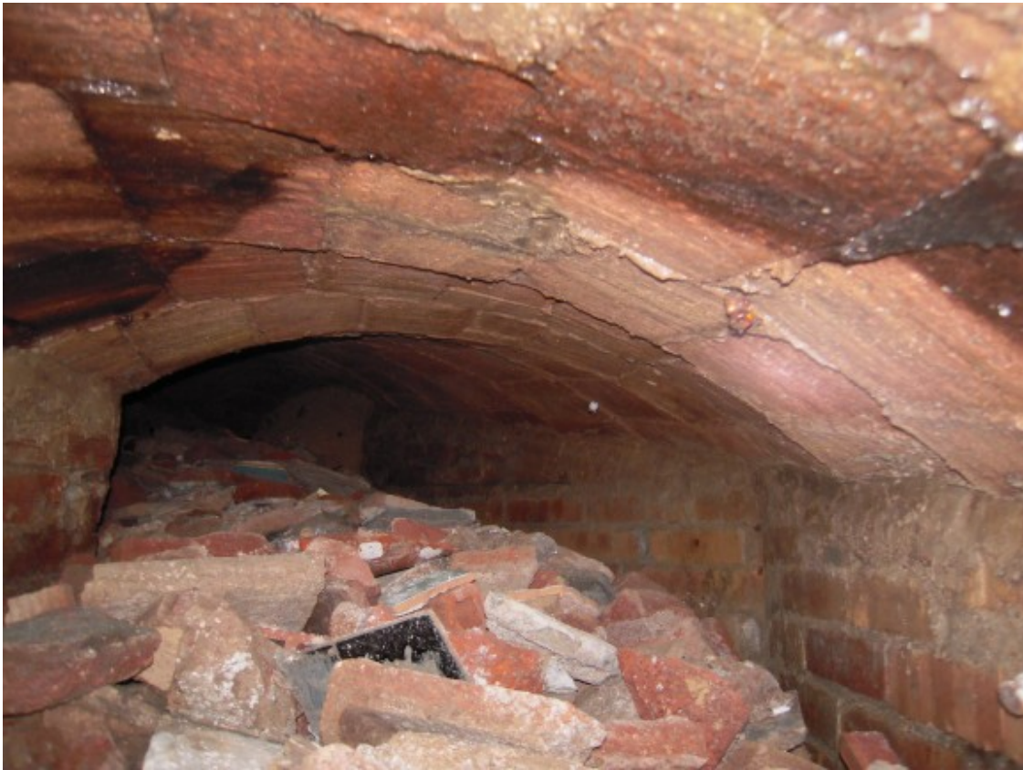
Runa a l'entrada del refugi antiaeri 547 al carrer Fernández Duró, al districte de Sants-Montjuïc, que va ser tapat després de la guerra. Foto: ICUB
