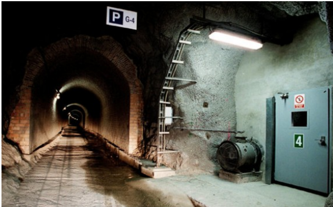
El túnel de serveis de Vallvidrera Foto: Túnel Barcelona Cadí
