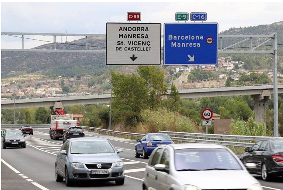
Entrada a l'autopista des de la C-55 a l'altura de Sant Vicenç | Montepio
