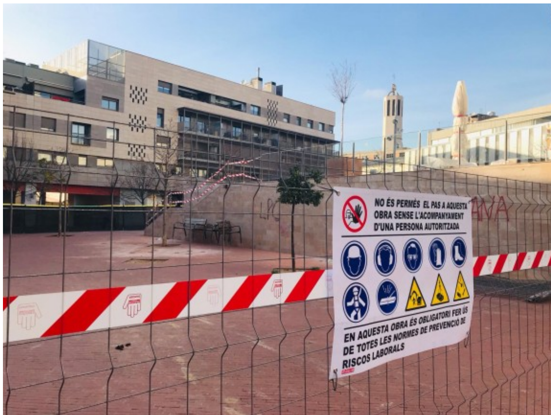
Obres de remodelació del Vapor Gran. Foto: Anna Mira
