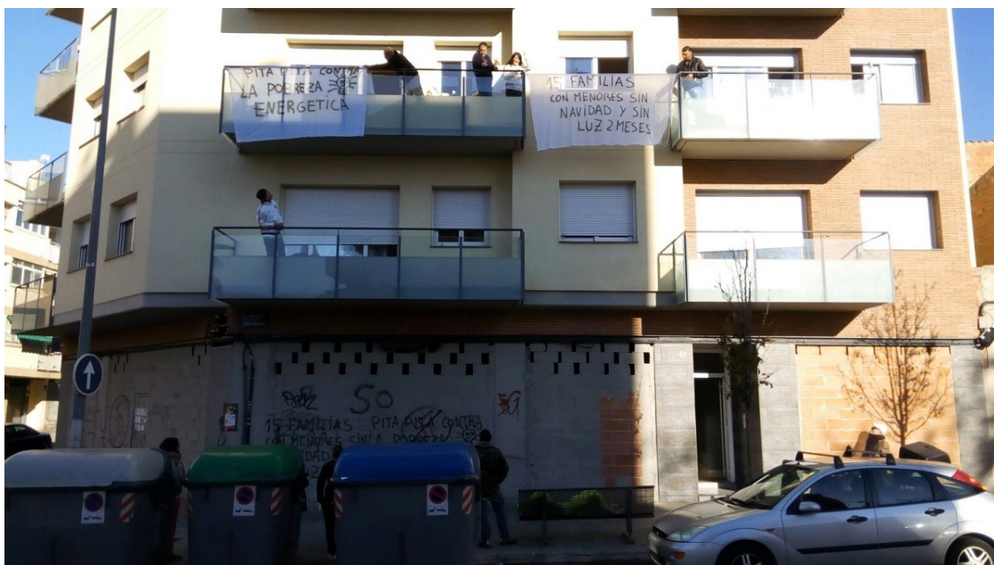
Façana d'un edifici ocupat a Terrassa. | CSVT
