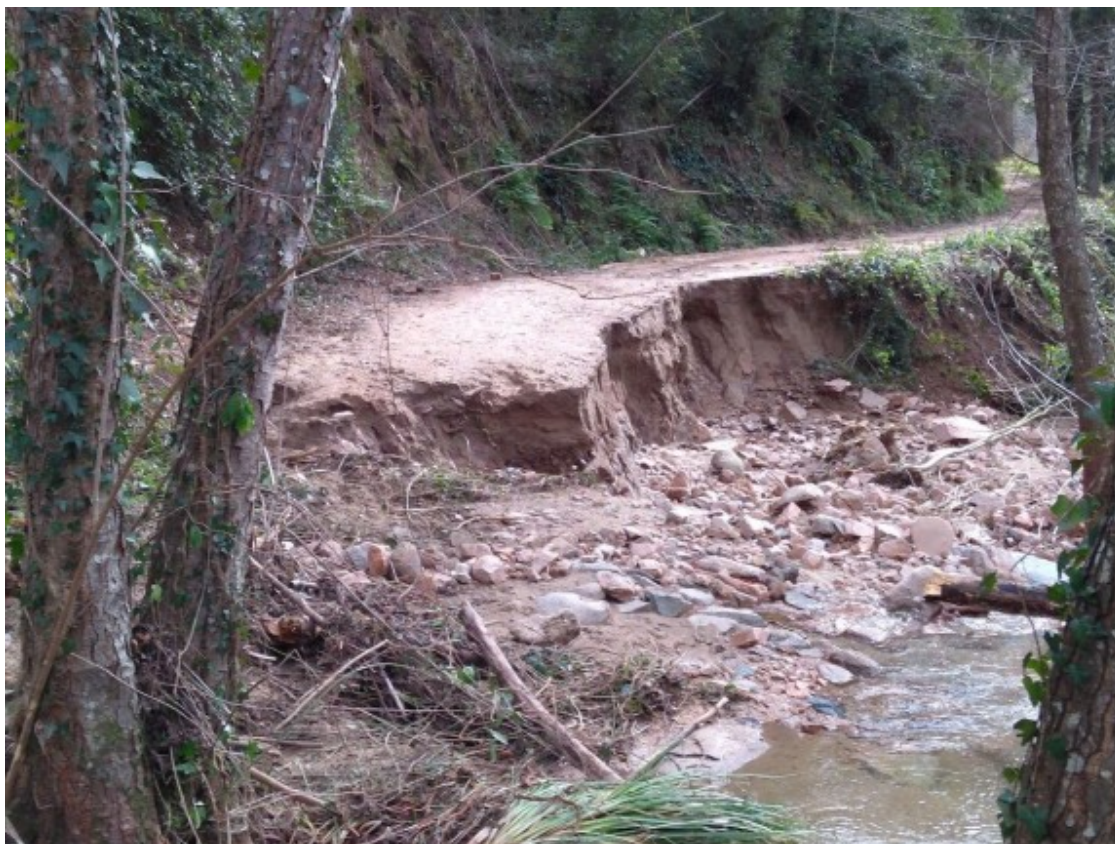
Un camí descalçat per causa de la llevantada de gener. Foto: @cfcatalunya.
