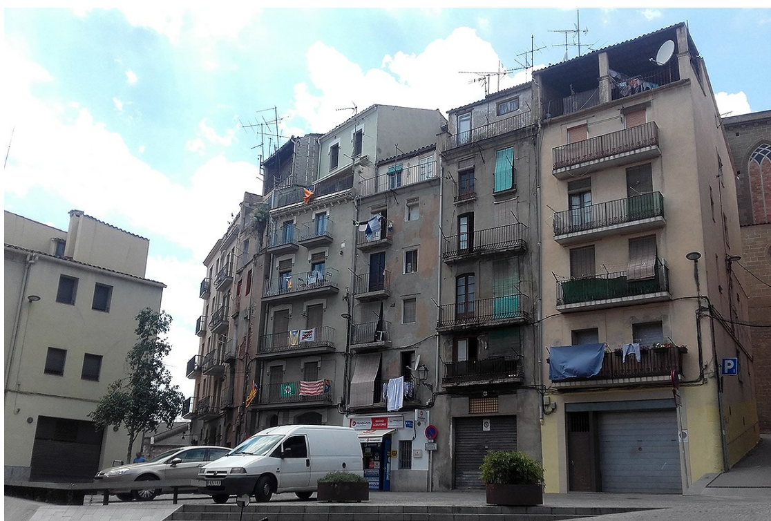
Habitatges al Barri Antic de Manresa | Pere Fontanals
