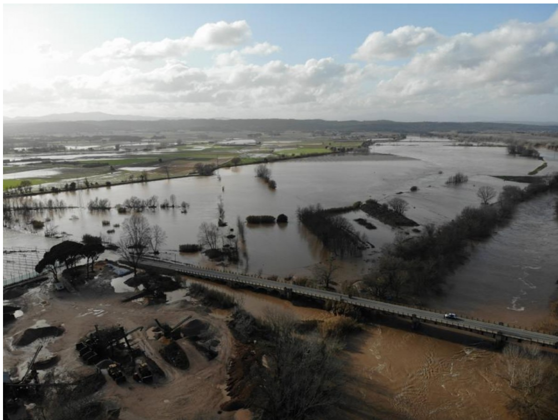
El pont del Ter, inundat a Verges | Bombers
