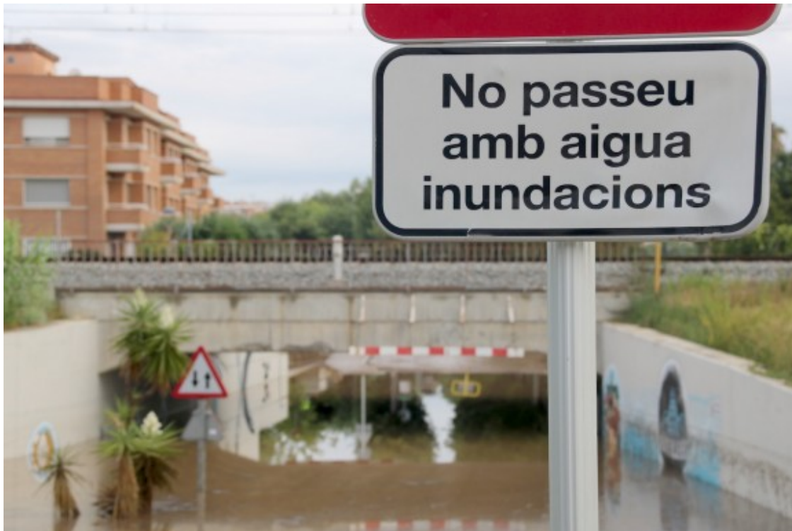
Un pas sota via de Cubelles, inundat. Foto: ACN
