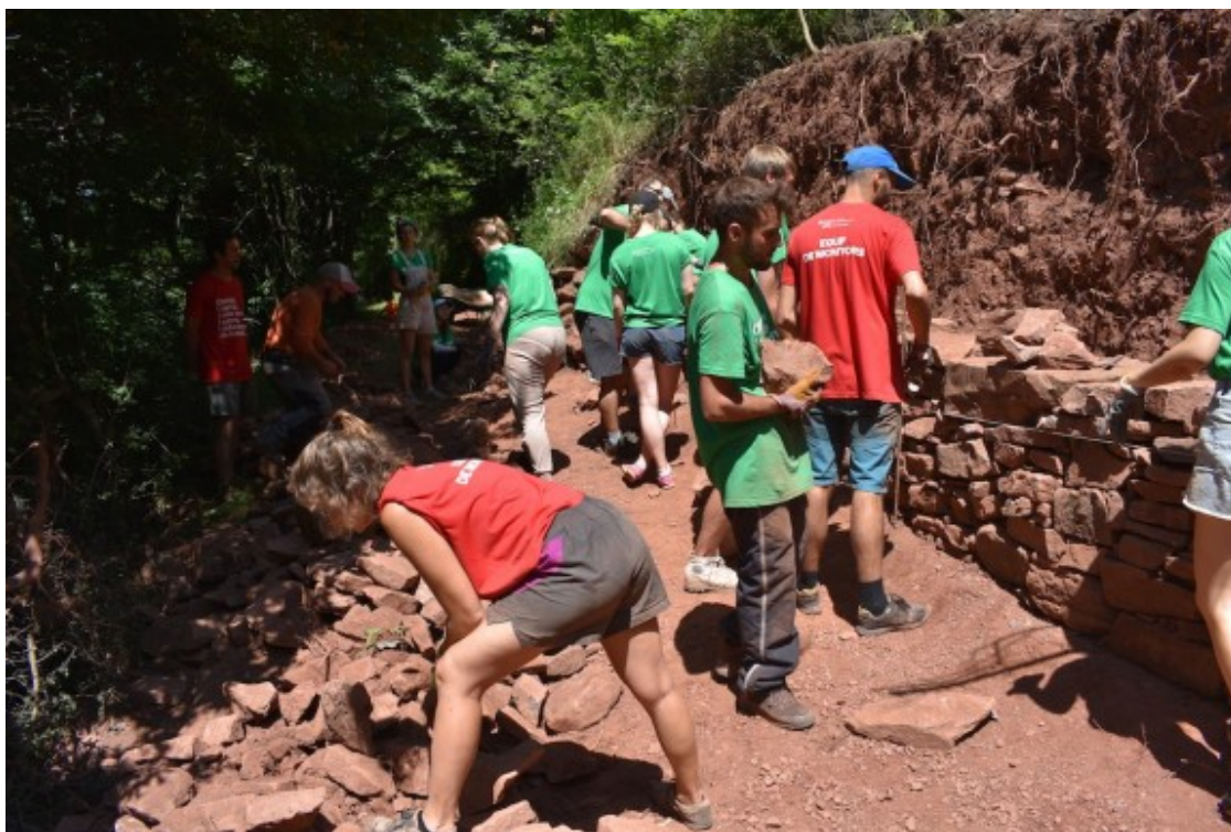
Voluntaris construint un mur de pedra seca a Llagunes. Foto: Refugi Vall de Siarb
