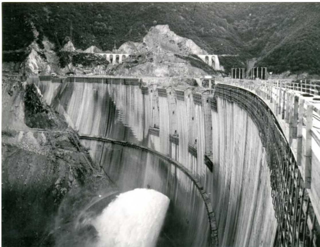
La bòveda de l'embassament de Susqueda en procés de construcció. Foto: Endesa.
