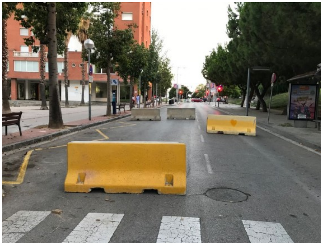
Barreres New Jersey instal·lades a un carrer de Mollet. Foto: Ajuntament de Mollet del Vallès
