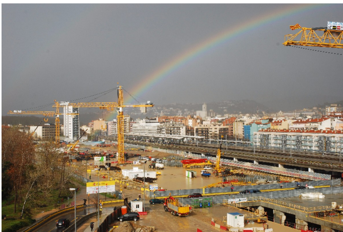
Les obres al Parc Central, ple de màquines i grues, al 2011 | Roger Zobl / Maite González
