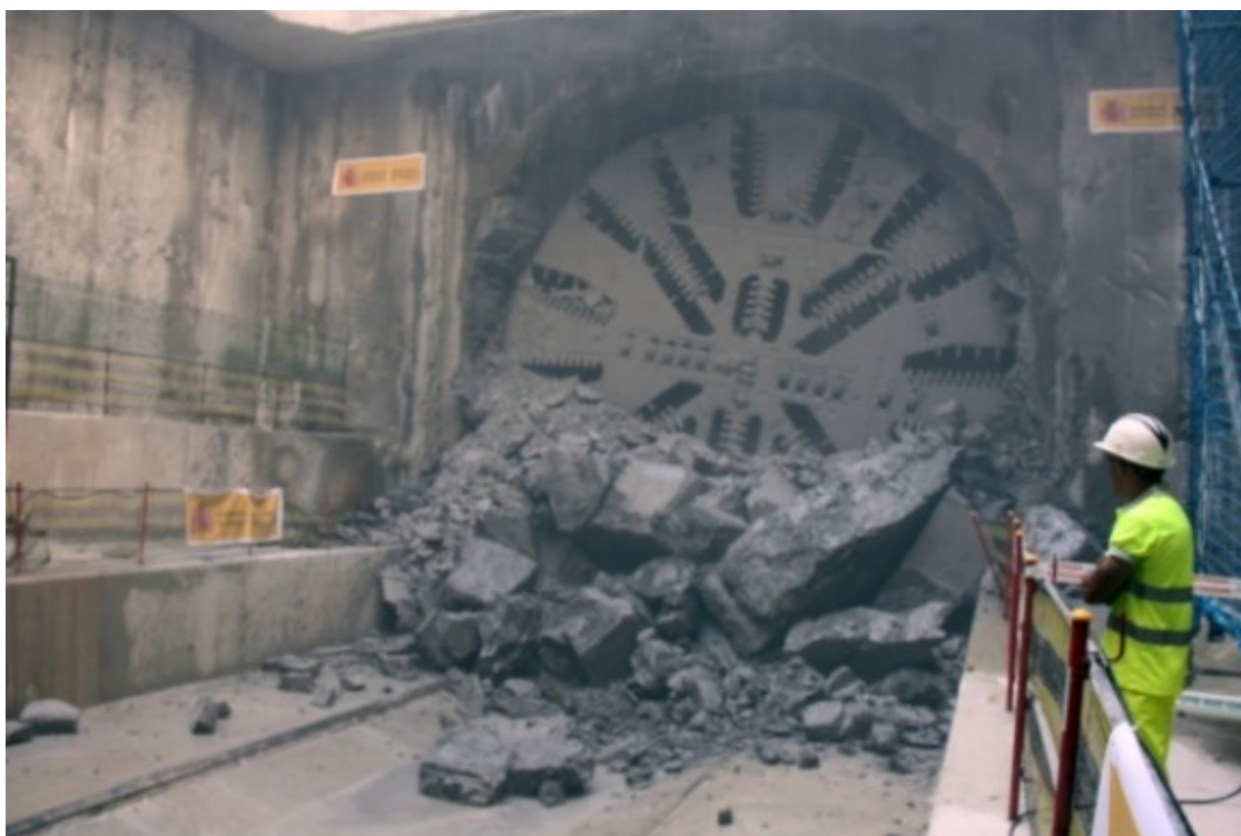
La tuneladora Gerunda perforant el subsòl gironí al 2012 Foto: ACN
