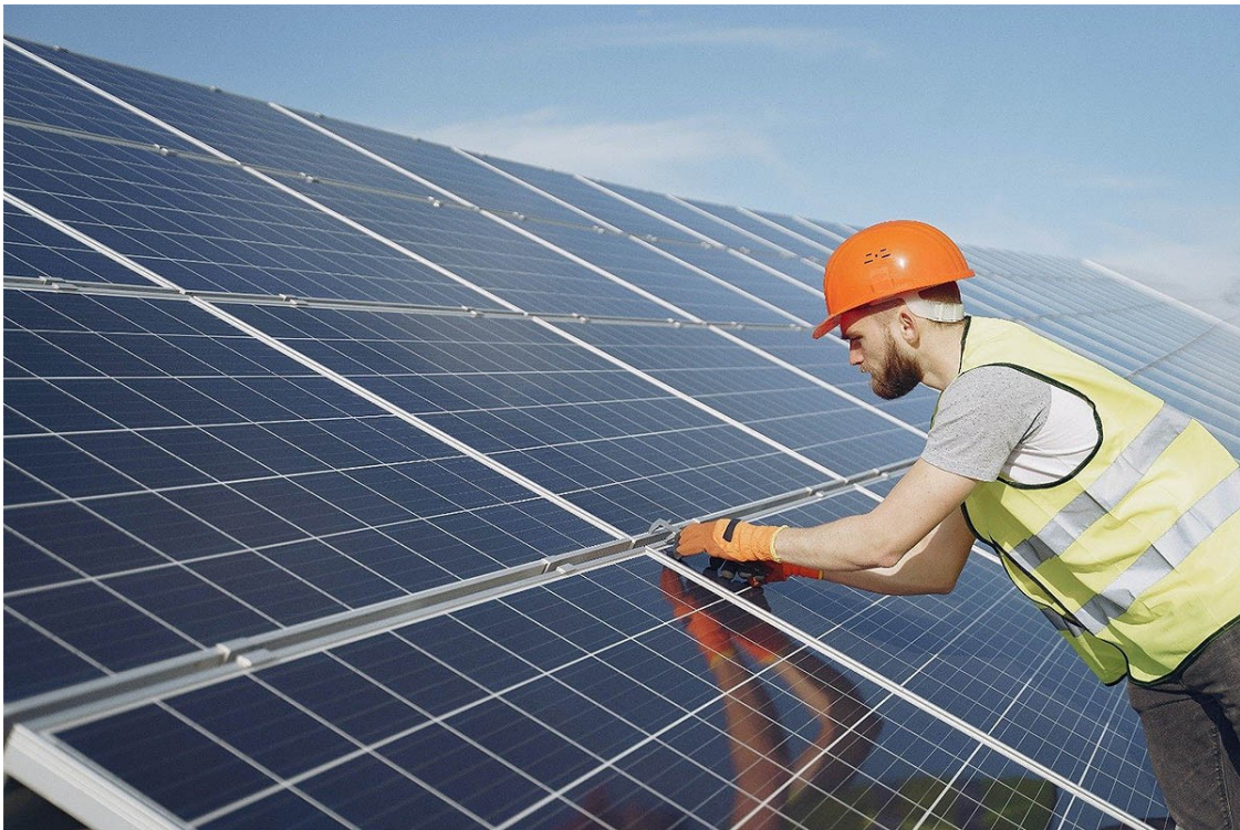
Un tècnic instal·lant plaques fotovoltaïques | ACN
