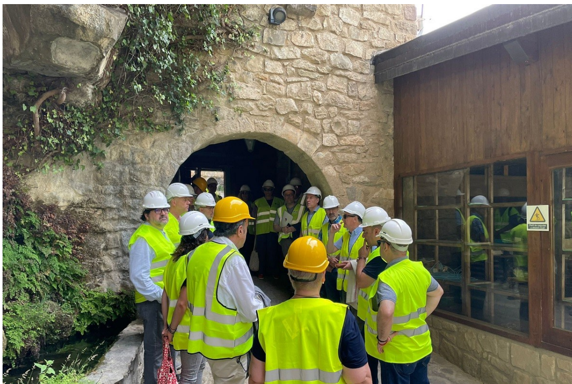
Visita de les autoritats a les obres de Sant Miquel del Fai | Diputació de Barcelona
