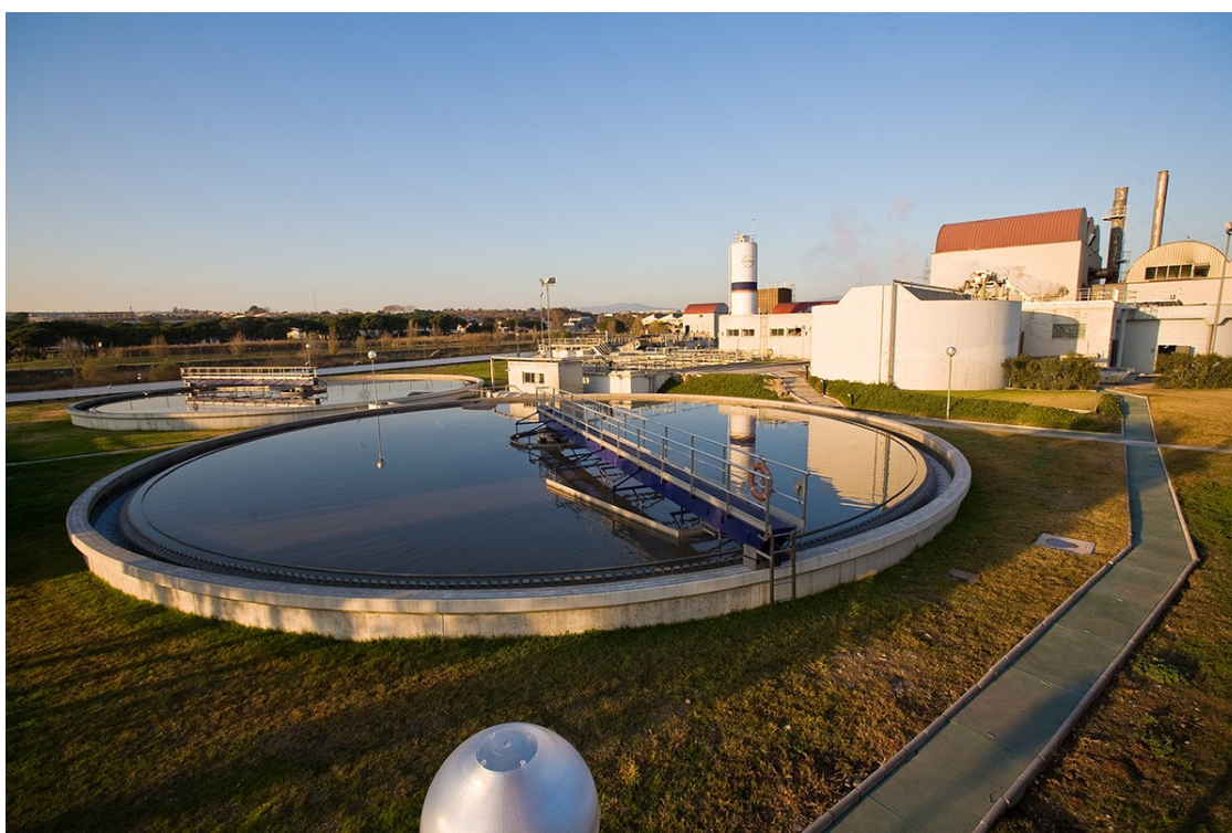
L'estació depuradora d'aigües residuals (EDAR) de Granollers | ACA
