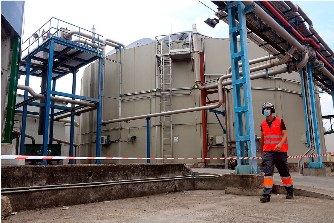
Una depuradora de Sarrià de Ter. | ACN
