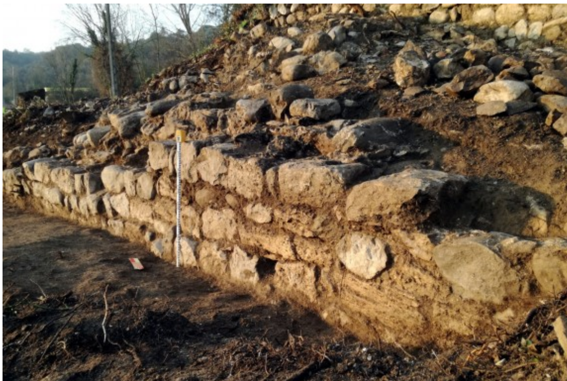
Pla general dels murs conservats de la casa forta a Fares. Foto: IPAT Serveis Culturals / Lluís Joan
