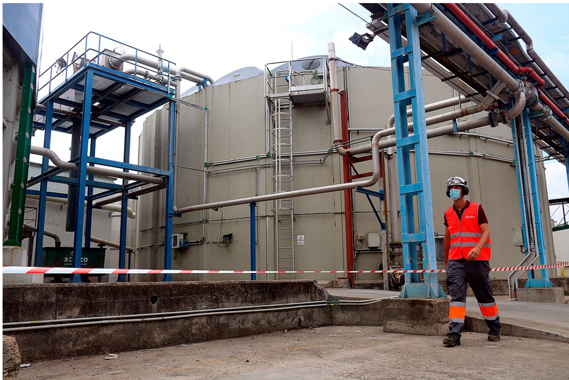
Una depuradora de Sarrià de Ter | ACN
