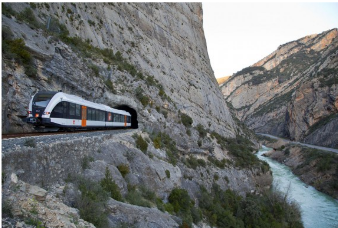
El Tren dels Llacs Panoràmic sortint d'un dels túnels de la línia. Foto: FGC
