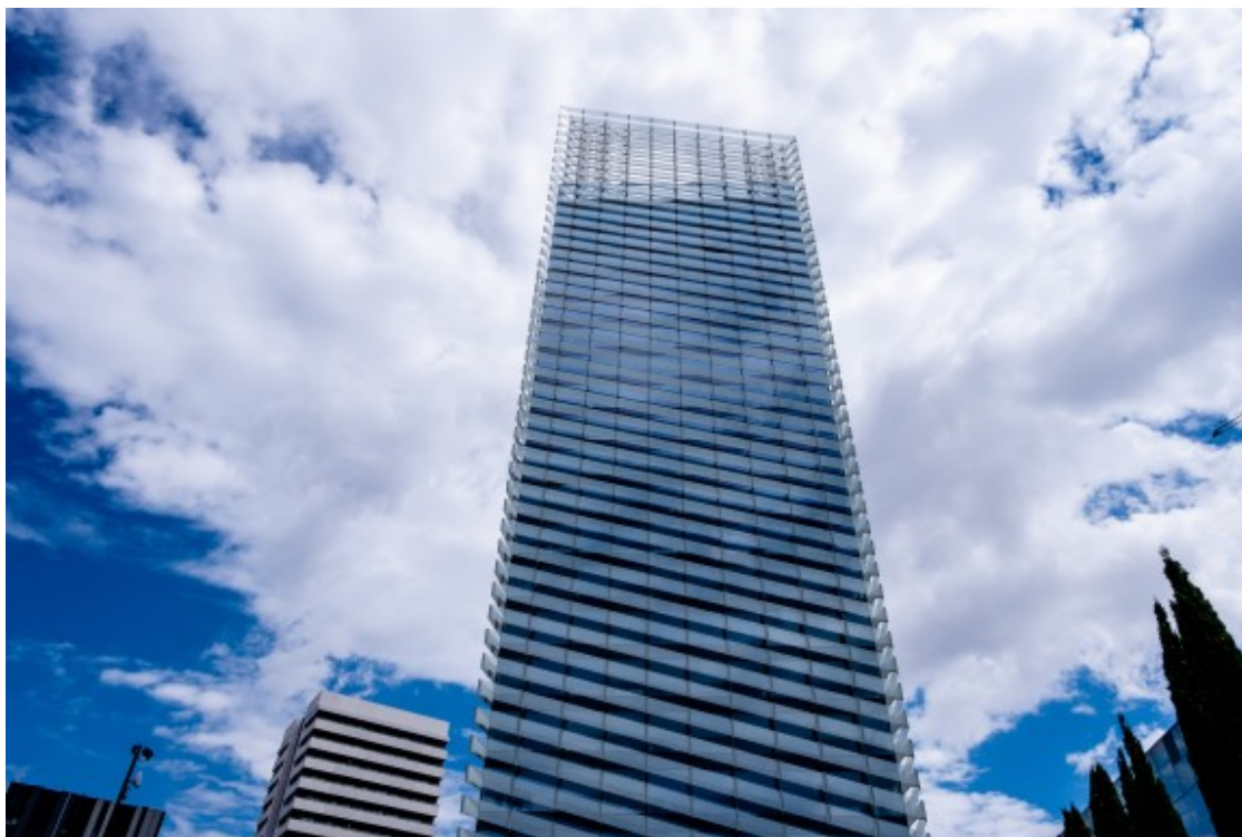
La Torre Puig, a l'Hospitalet de Llobregat. Foto: Adrià Costa.
