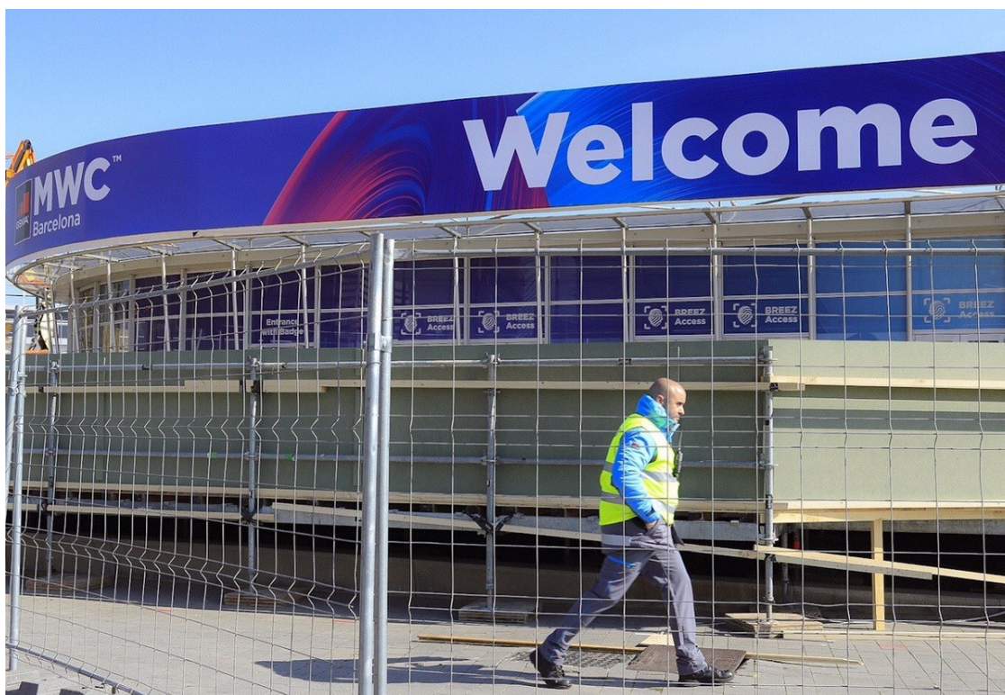
Operaris desmuntant la infraestructura del congrés | Georgina Albreda
