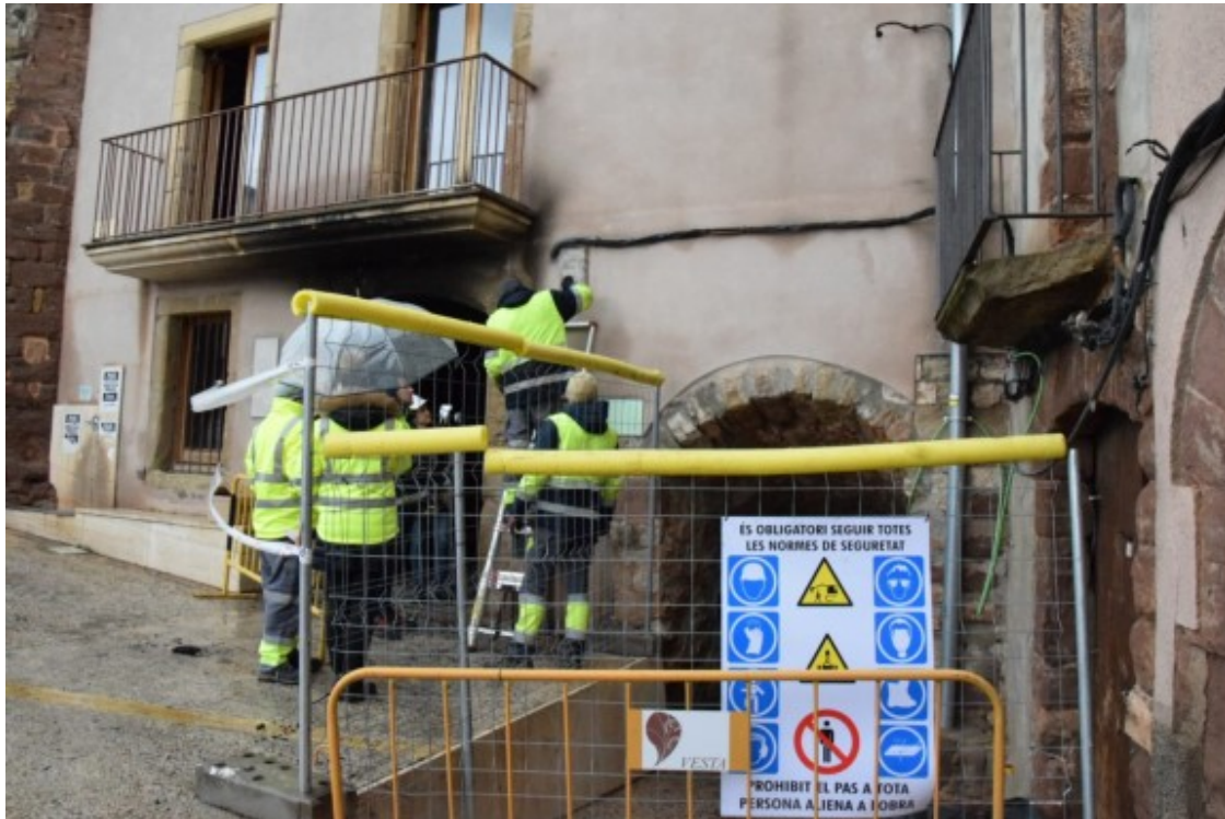
Operaris substitueixen el cablejat elèctric cremat a l'entrada del museu. Foto: Cedida
