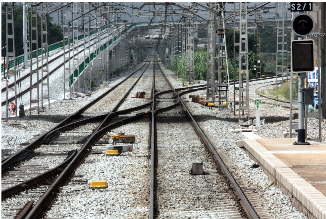
Un encreuament de vies, a la línia R8 de Rodalies. | Norma Vidal
