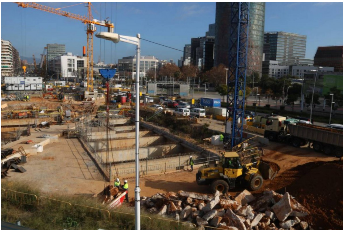
Obres de la plaça de les Glòries de Barcelona | ACN
