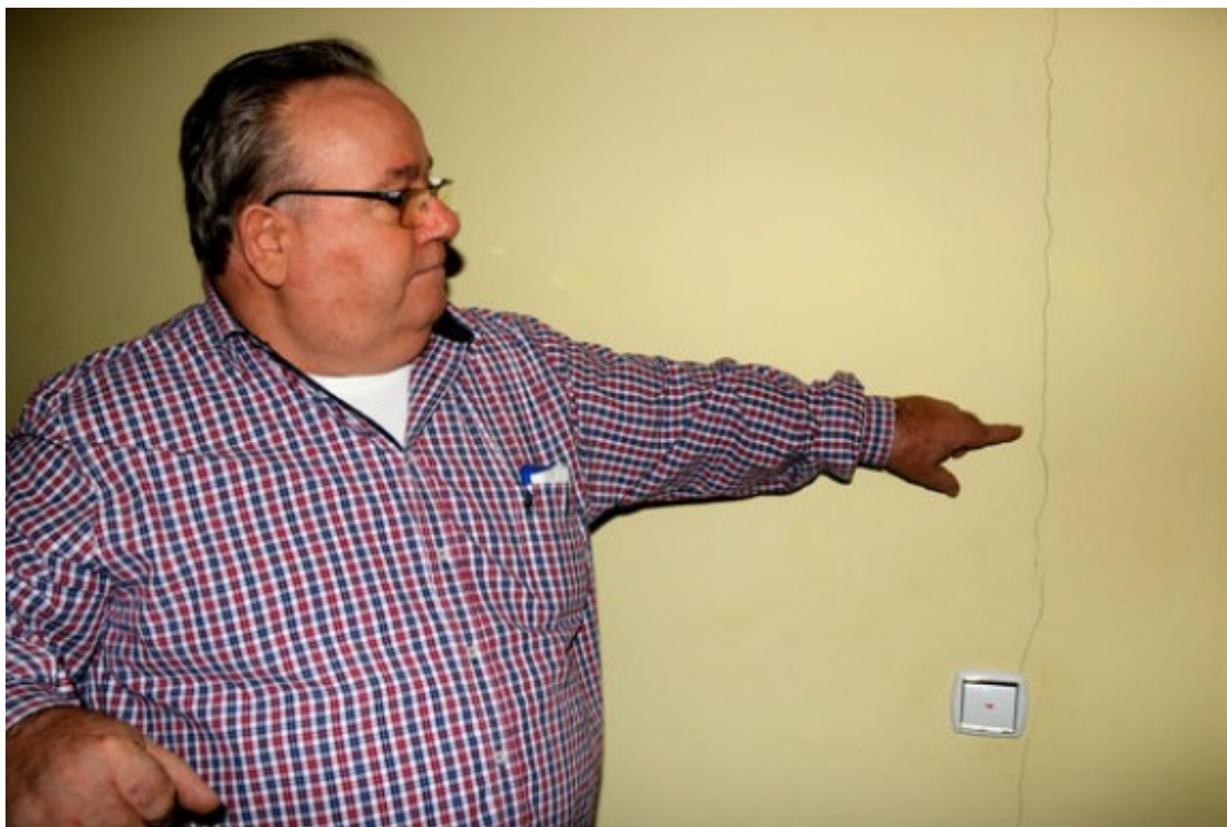
Un veí ensenya les esquerdes provocades pels sismes Foto: ACN
