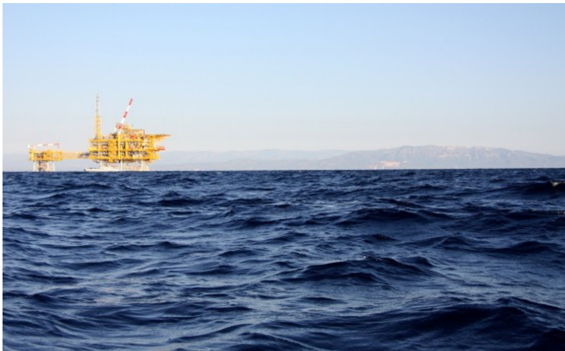
Vista de les instal·lacions del magatzem submarí del Castor des del mar. Foto: ACN / J. Marsal
