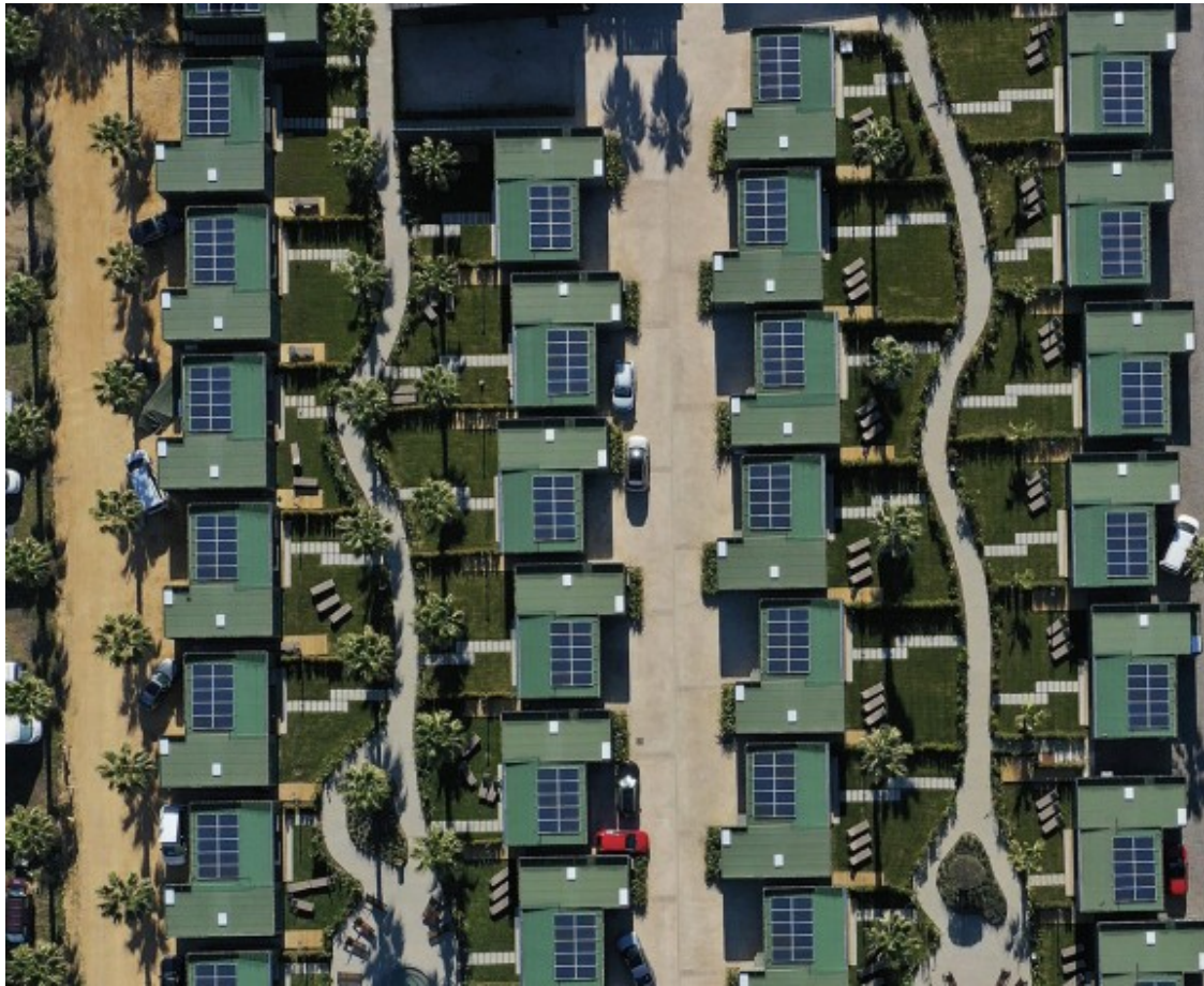
Els nous bungalows sostenibles, a vista de dron. Foto: La Ballena Alegre
