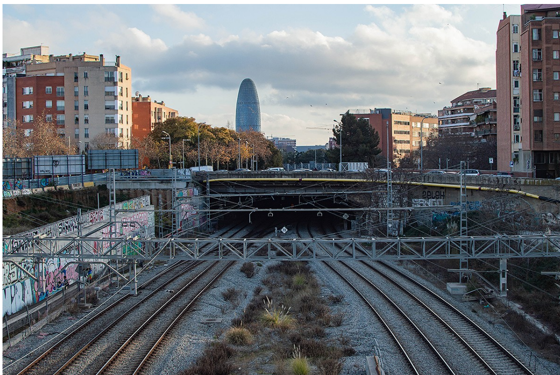
Obres de l'accés de l'AVE a l'estació de la Sagrera | Martí Juanola
