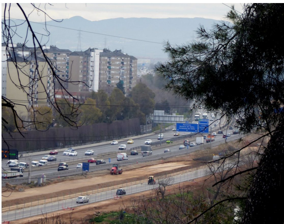
Les obres a la C-58 a l'alçada de Badia | Albert Hernández
