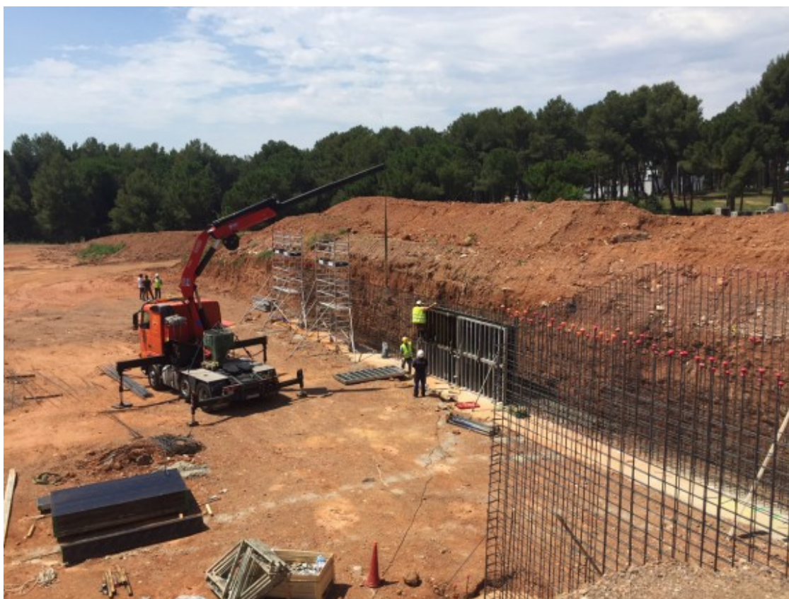
Obres del nou camp d'hoquei municipal de Matadepera Foto: Anna Mira
