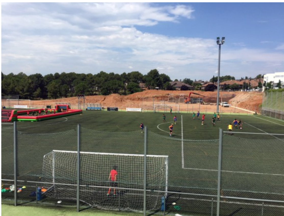
Obres del nou camp d'hoquei municipal de Matadepera Foto: Anna Mira
