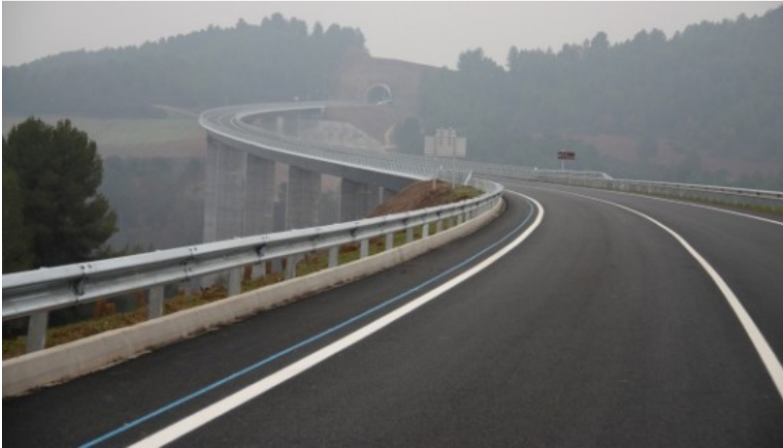
Viaducte de Rajadell, a l'eix diagonal, des d'on va intentar saltar l'home. Foto: Mar Martí
