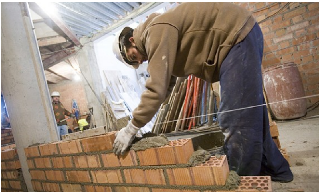
Un treballador de la construcció aixecant una paret | Adrià Costa
