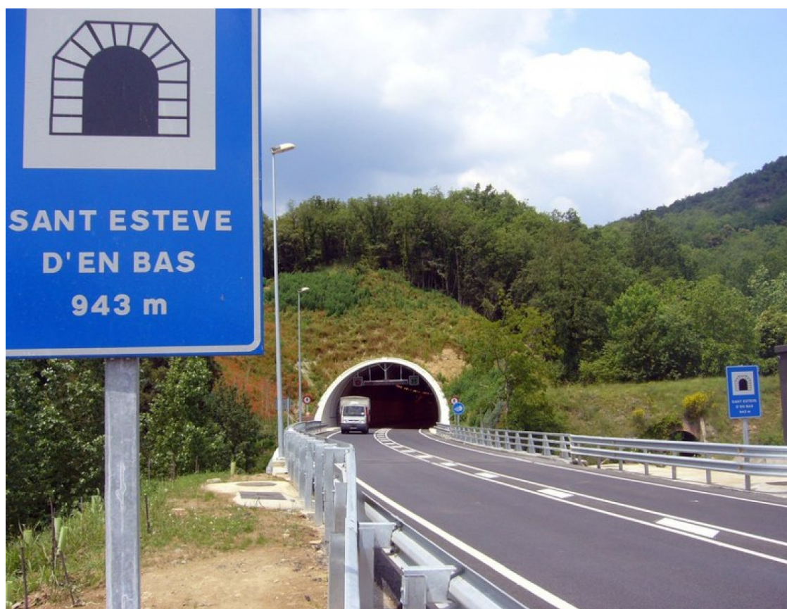
El túnel de Sant Esteve d'en Bas a la C-63. | Arxiu NG.
