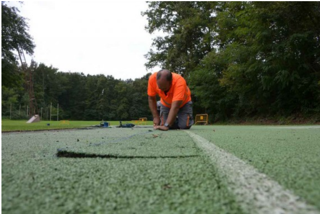
Un treballador feineja en la rehabilitació de la pista d'atletisme. Foto: @olotuit.
